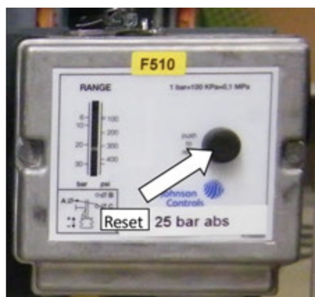
Рис. 19: Кнопка сброса ограничителя высокого давления
